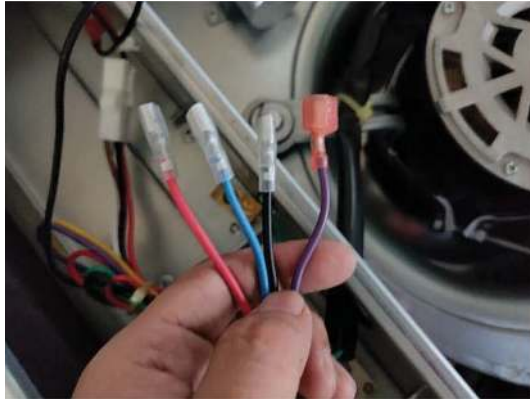
Fig. 3 – Remove Motor Wires
