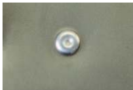
RISULTATO DELLA POSA DI UN RIVETTO FLOW-FORM
