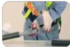
PVC glue on the T-joint
